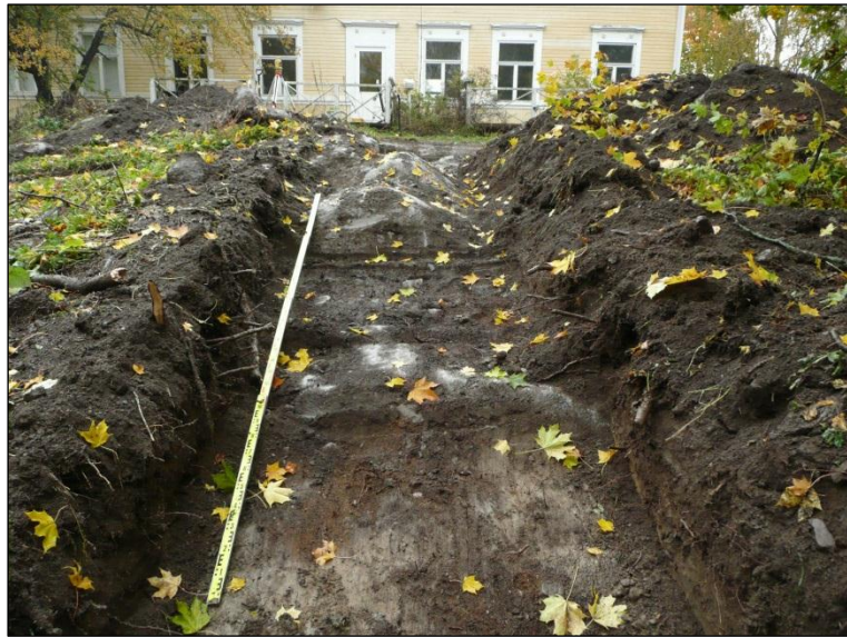
Eteläistä kaistaa kumpareen juurelta, kallio esiin kaivettuna
